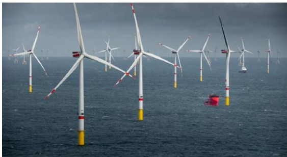
Foto: Usina eólica offshore/ DW Energy
