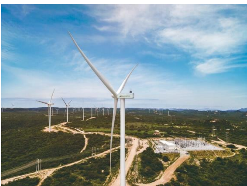
Complexo de Energia Renovável da Neoenergia na Paraíba/Foto: Neoenergia
