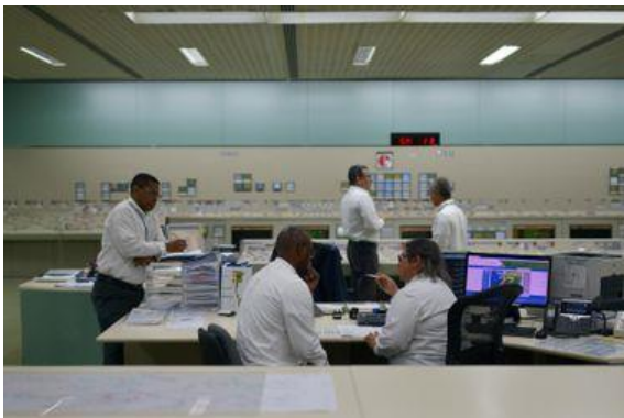
Sala de controle da usina nuclear de Angra 2; finalização da usina de Angra 3, várias vezes adiada, caminha a passos lentos. Foto: Lucas Landau/Reuters
