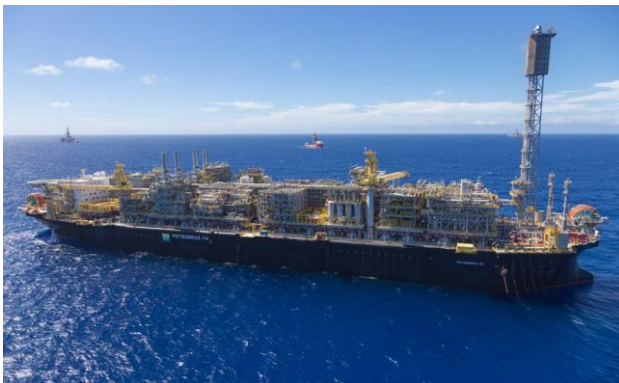
Plataforma P-74, da Petrobras, em operação no campo de Búzios, no pré-sal da Bacia de Santos — Foto: Andre Ribeiro/Banco de Imagens Petrobras/Divulgação
