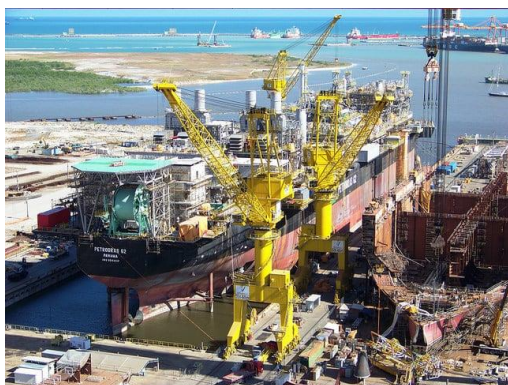
Plataforma P-62, construída no estaleiro Atlântico Sul, em Pernambuco (Foto: Divulgação)
