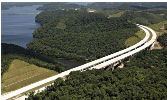
Rodoanel Norte, no Estado de São Paulo — Foto: Divulgação/Governo do Estado de São Paulo
