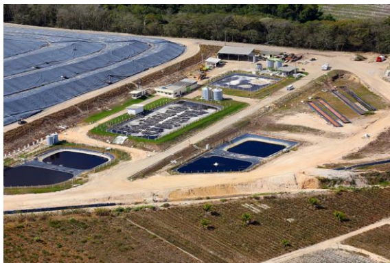
Central de Tratamento de Resíduos (CTR) Pernambuco na Região Metropolitana de Recife /Foto: divulgação
