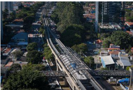
Obras da Linha 17-Ouro do Monotrilho na altura da estação Vila Cordeiro; construção se arrasta desde 2011 Foto: FELIPE RAU/ESTADÃO
