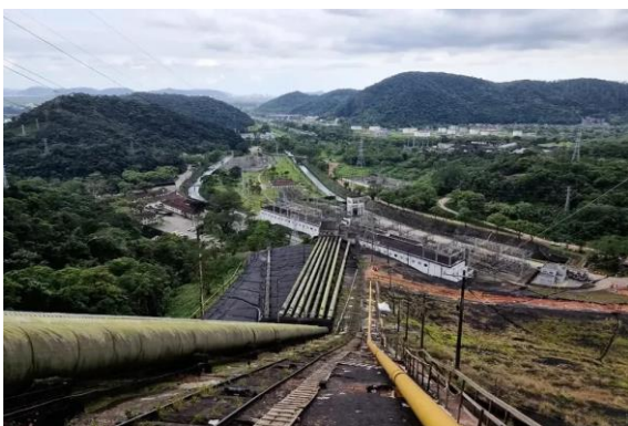
Gasoduto Subida da Serra da Comgas — Foto: Sima/SP
