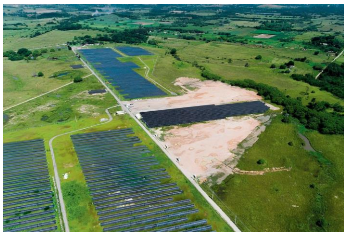
Instalação de planta solar da Karpowership em Itaguaí, no RJ — Foto: Divulgação
