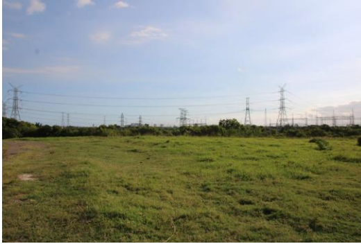
Usina fotovoltaica, em Santa Cruz, foi batizado de Solário Carioca — Foto: Divulgação
