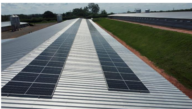
Placas fotovoltaicas na granja do avicultor Flávio de Souza, no Alto Paraná (PR) — Foto: Divulgação
