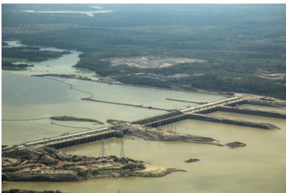
Usina hidrelétrica de Santo Antônio, no Rio Madeira, em Porto Velho — Foto: Edilson Dantas / Agência O Globo
