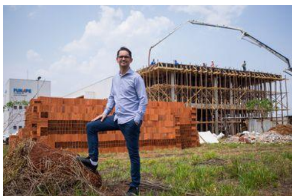
Diretor do Parque Tecnológico Samambaia, Luizmar Adriano Júnior, em obras para ampliar estrutura física, laboratórios e espaços para abrigar empresas Foto: Tiago Queiroz
