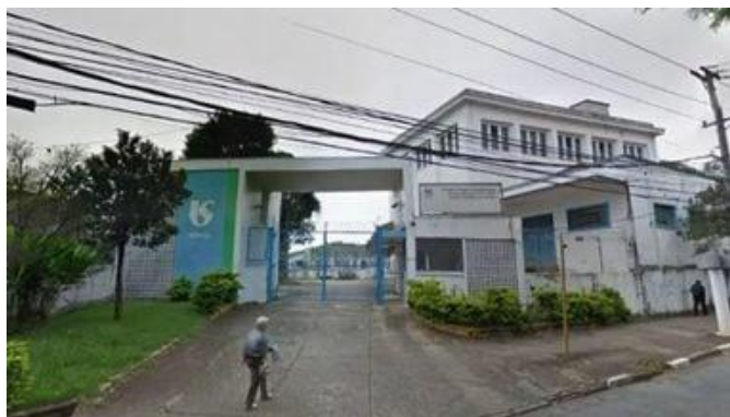
Estação de água da Sabesp. Foto: Google Streetview
