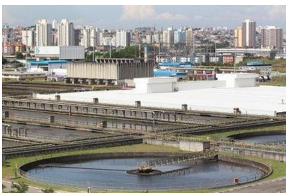
Estação de tratamento de esgoto da Sabesp; empresa é uma das maiores de saneamento do mundo Foto: Márcio Fernandes/Estadão
