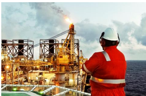
Produção de petróleo em plataforma da Petrobras (Foto: Agência Petrobras)
