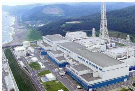
Usina nuclear de Kashiwazaki-Kariwa operada pela Tepco no Japão (Foto Divulgação Tepco)
