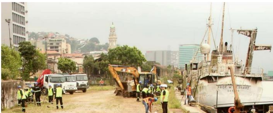
A entrega da primeira fase da obra está prevista para o fim do primeiro semestre deste ano e já há potenciais interessados em investir não só na região do parque, mas no seu entorno
