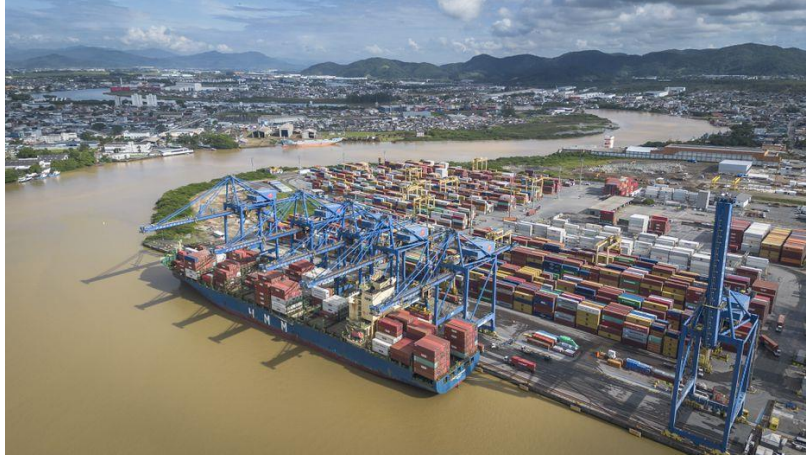
Obras no Porto de Navegantes para ampliar capacidade devem durar 27 meses Foto: ANDERSON COELHO / ESTADÃO
