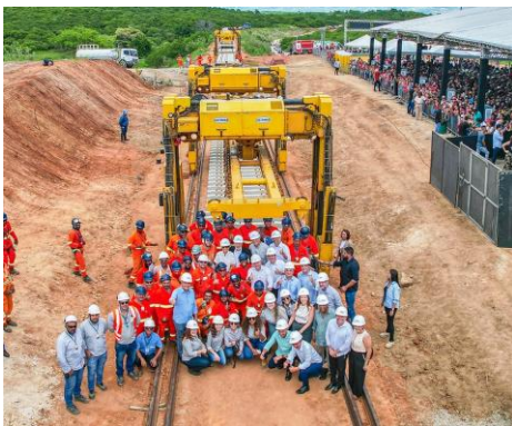
Visita de Lula a obras da Ferrovia Transnordestina, no Distrito Suassurana, em Iguatu (CE) — Foto: Ricardo Stuckert / PR
