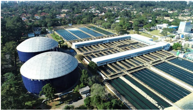
Estação de Tratamento de Água (ETA) Alto da Boa Vista, da Sabesp — Foto: Divulgação/Sabesp
