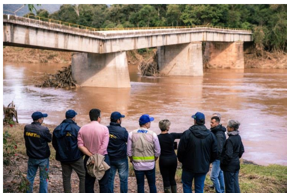
Ministro Renan Filho e o diretor-geral do DNIT, Fabrício Galvão, vistoriam obras de recuperação com autoridades no RS - FOTO: Marcio Ferreira/MT
