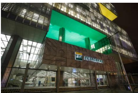
Fachada do edifício sede da Petrobras (Edise), na avenida Chile, no centro do Rio de Janeiro (Foto: Flávio Emanuel/Agência Petrobras)
