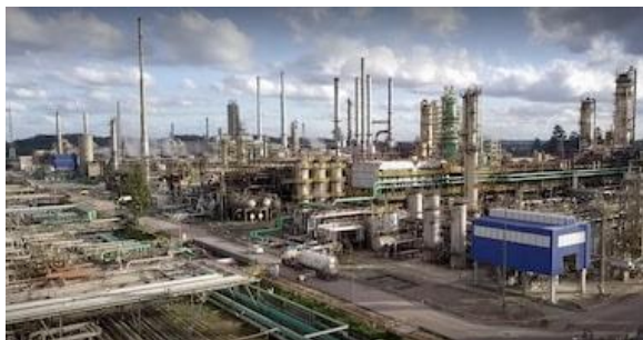
Fábrica de fertilizantes Araucária Nitrogenados (ANSA), no Paraná, está desativada desde 2020 Foto: Petrobras/Divulgação
