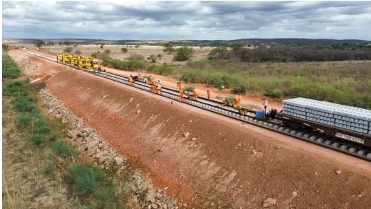
Trecho da Transnordestina em obras - Divulgação/TSLA
