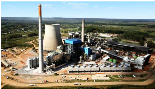
Termelétrica a carvão mineral Candiotá III, no Rio Grande do Sul Foto: Divulgação/CGT Eletrosul Para você
