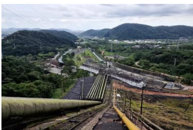
Gasoduto Subida da Serra, da Comgás (Foto: Sima/SP)
