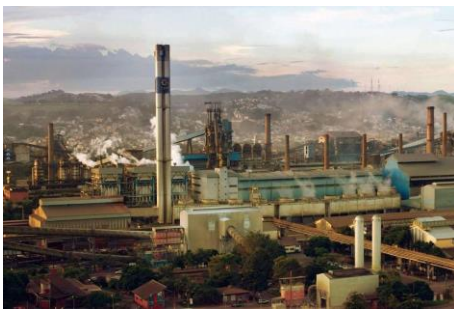
Usina de aço da CSN em Volta Redonda (RJ), onde a empresa montou sua primeira fábrica de cimento, em 2009 Foto: Divulgação/CSN
