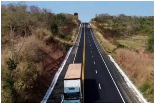
*O trecho que conecta Jataí e Caiapônia recebeu serviços como fresagem, recomposição, microrrevestimento asfáltico, nova sinalização e manutenção entre os km 155 e 240. Foto: Reprodução/Dnit*
