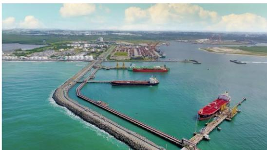
**Operação de bunker: combustível será bombeado do terminal da Ultracargo para uma barça através do Píer de Granéis Líquidos – PGL 1. Foto: Porto de Suape/Divulgação**
