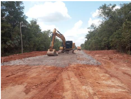
Rodovia BR-319 em 52 km de extensão autorizados - FOTO: Divulgação/DNIT
