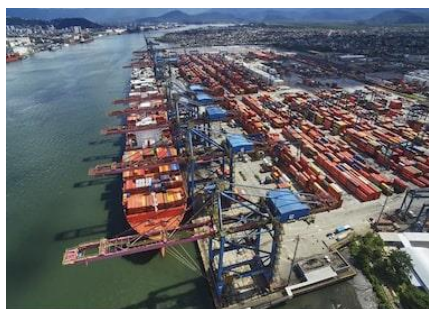
Terminal da operadora Santos Brasil no porto santista: novo terminal, o STS10, conforme Ministério de Portos vai elevar capacidade em Santos para contêineres em 50% Foto: Porto de Santos/Divulgação
