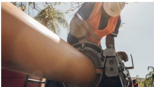
Obra na rede de distribuição da CEG, controlada pela Naturgy (Foto: Divulgação)
