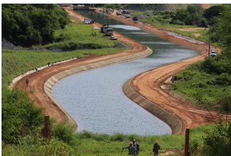
Cinturão das Águas: obra para garantir abastecimento no Ceará/Foto Secom-CE
