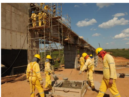
Obras da Transnordestina — Foto: Luis Ushirobira/Valor
