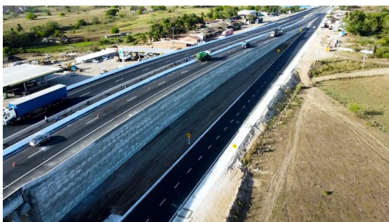
Novo viaduto em Porto Real do Colégio (AL) melhora acesso aos estados de Alagoas e Sergipe. Foto: DNIT
