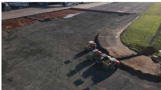
Obras de recuperação da pista — Foto: Divulgação
