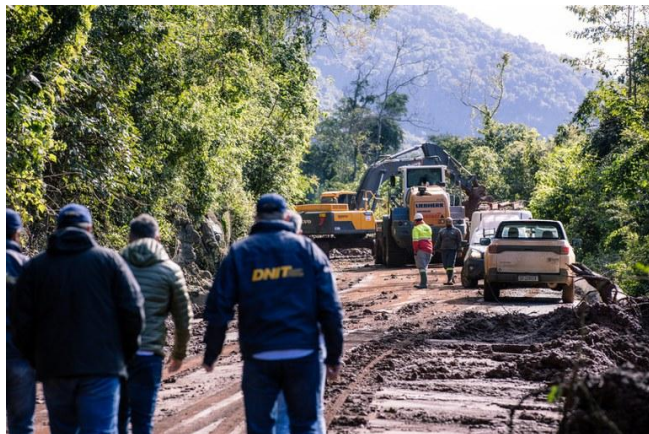
Visita técnica BR-470, Ponte sobre o Rio das Antas - Foto: Marcio Ferreira/MT
