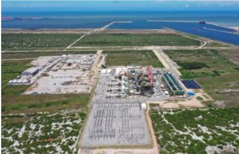
**A usina termelétrica Portocem I, em Barcarena, operará em ciclo simples, com capacidade instalada de 1.571,9 MW, alimentada por quatro turbogeradores de 392,97 MW cada**
