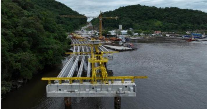
**A obra prevê uma ponte com 1.244 metros de extensão, quatro faixas de tráfego, duas faixas de segurança, barreiras rígidas de concreto, calçadas com ciclovia e guarda-corpo**
