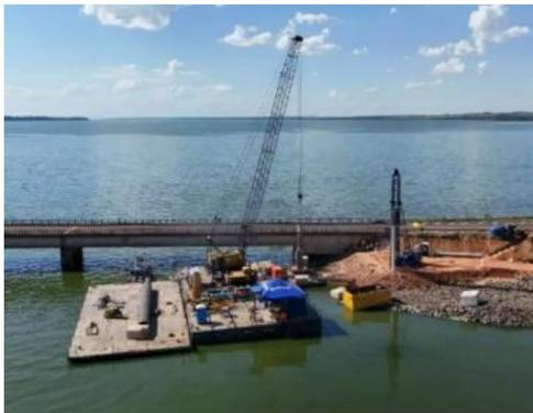
**O método construtivo utilizado no vão central, de 125 metros, será o de Balanços Sucessivos, garantindo a navegabilidade da Hidrovia Tietê-Paraná durante as obras (Foto: Divulgação/Entrevias)**
