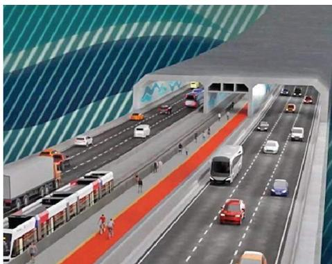
A estrutura total será de 1,5 km, sendo 870 metros submersos. O túnel contará com três faixas de rolamento por sentido, sendo uma delas para a passagem do Veículo Leve sobre Trilhos (VLT). Também haverá acesso exclusivo para pedestres e ciclistas.
