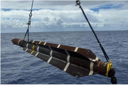
A Seagems finalizou um projeto de instalação de quatro estacas torpedo no campo de Mero 3, na Bacia de Santos, em uma operação contratada pela Subsea7. O diferencial do projeto foi o uso do navio Esmeralda, um PLSV (lançamento de linhas), para a execução integral da instalação, substituindo embarcações tradicionais do tipo AHTS (manuseio de âncoras).
