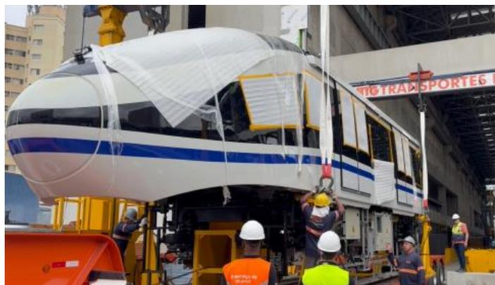
**A operação de descarregamento contou com um braço mecânico que retirou os carros das carretas e os colocou nas vigas para a realização da montagem completa da composição**
