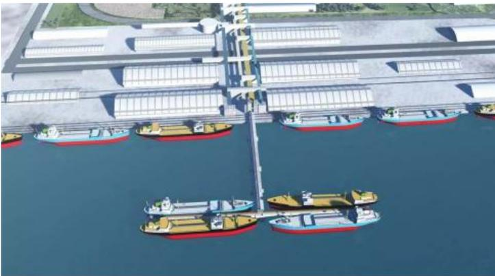
***A primeira fase da obra inclui a construção da ponte entre o cais e os dois novos berços. Na segunda fase, o segundo píer será construído, completando o “T” com mais dois berços***
