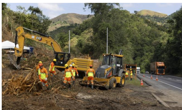
Obras na Serra das Araras, na Via Dutra — Foto: Márcia Foletto / Agência O Globo / 28-05-2024
