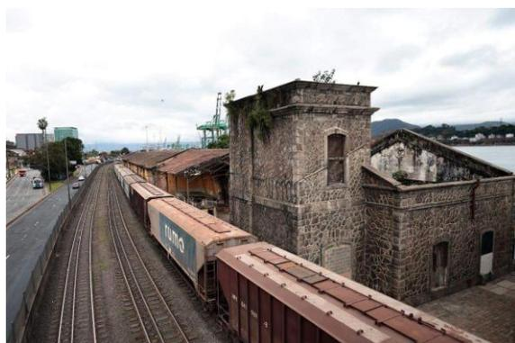
Ainda de acordo com a Prefeitura, após alguns serviços de demolição, o Armazém 3 receberá restauração da fundação, recuperação da estrutura metálica, infraestrutura de elétrica, hidráulica e drenagem, além de recuperação da fachada do lado da linha férrea. O galpão tem 2.127 m<sup>2</sup> e seu entorno e a Casa de Pedra somam 2.610 m<sup>2</sup>, perfazendo uma área total de 4.737 mil m<sup>2</sup>.
