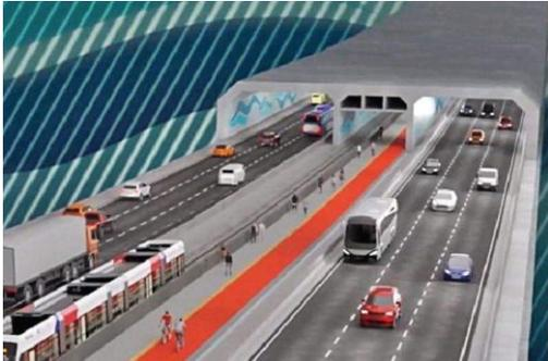
**Com 1,5 quilômetro de extensão, sendo 870 metros submersos, túnel contará com três faixas por sentido (Reprodução)**
