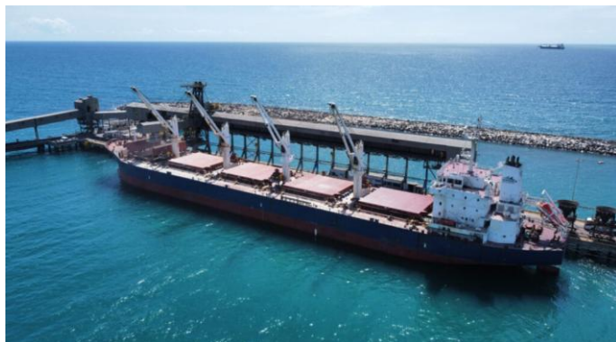
Terminal Marítimo Inácio Barbosa (TMIB)/ Foto: Arthur Paganini
