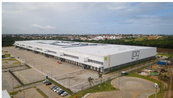
Galpão da Log em João Pessoa – Foto: Divulgação
