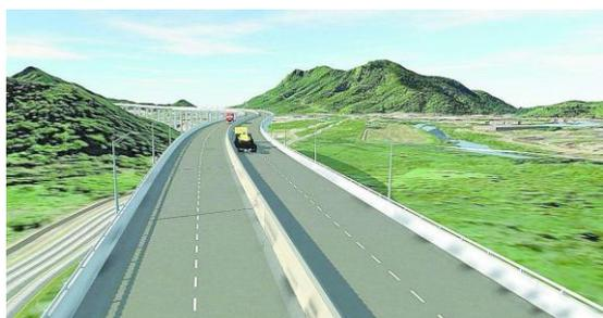
**A proposta prevê duas faixas de rolamento por sentido, para 20 mil veículos por dia, com acostamento e dimensionadas para tráfego pesado (Reprodução)**
